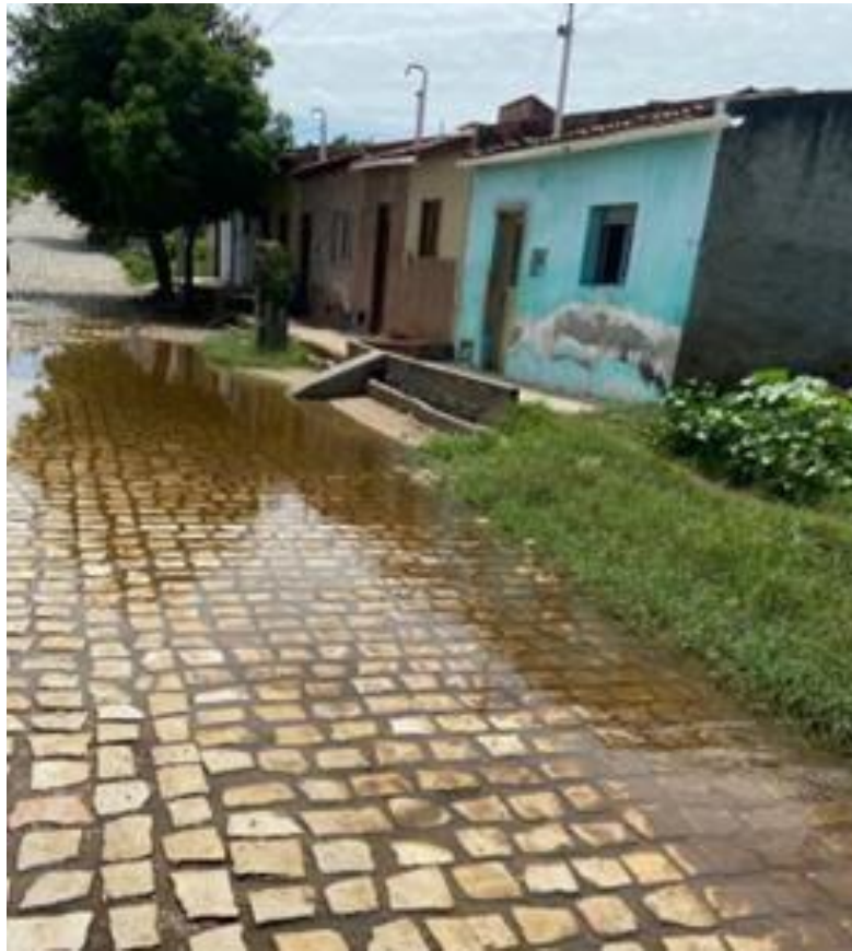
Figura 8: Rua alagada do bairro CAIC após chuvas.
