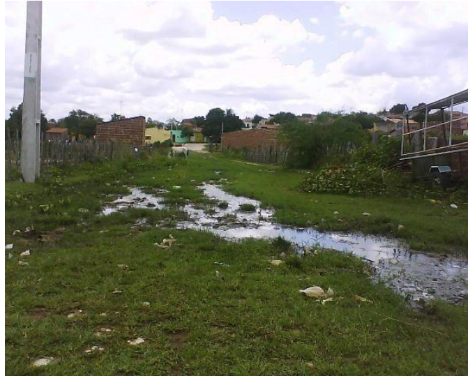
Figura 9: Área urbana do bairro CAIC que não são pavimentadas em período de chuvas.
