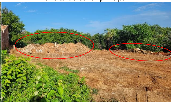
Figura 17: Presença de entulho na margem direita do canal principal.
