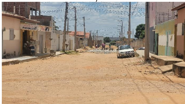
Figura 7: Pavimentação da Rua Francisco Alcino do Pinho, bairro Dom Elizeu, (microbacia IV).
