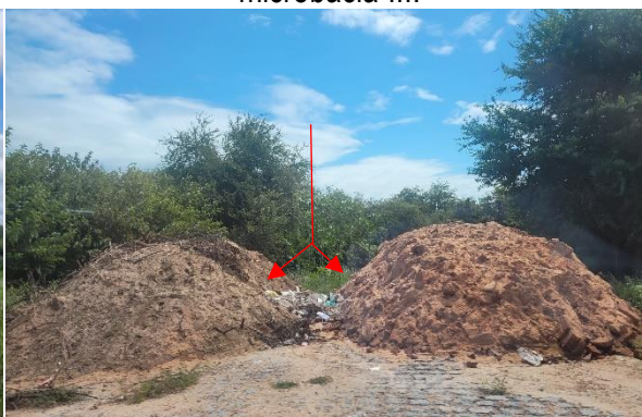
Figura 19: Entulho, resíduos sólidos e pilhas de areia à margem direita do canal principal da microbacia III.
