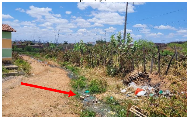
Figura 23: Efluente a céu aberto in natura , advindo das residências na margem esquerda do canal principal.
