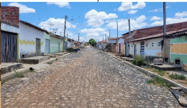
Figura 8: Pavimentação da Rua Padre Manoel Silvério Cabral, bairro Frutílândia, (microbacia VI).
