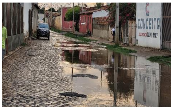
Figura 26: Alagamento na Rua Onze de Agosto, no dia 03/12/2022
