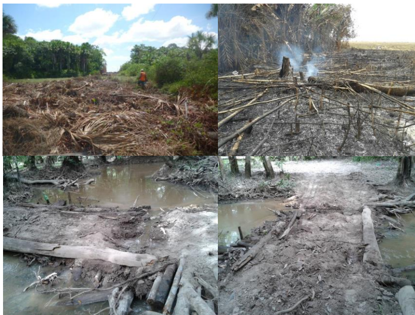
Figura 4: Construção de um ramal para acesso às terras do Quilombo de Conceição do Macacoari.
