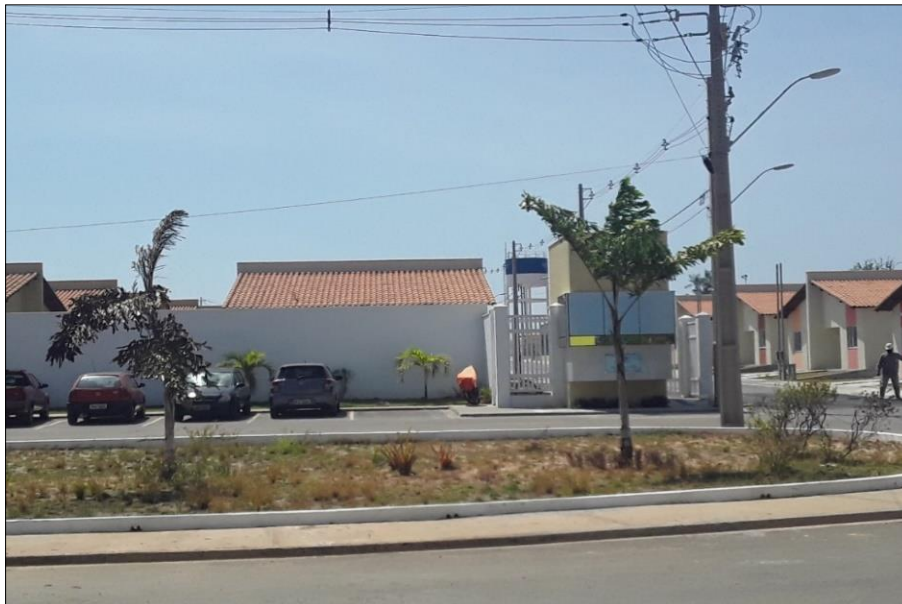
Figura 5 - Condomínio fechado em obras no polo agrícola do Iguaiá-2020.
