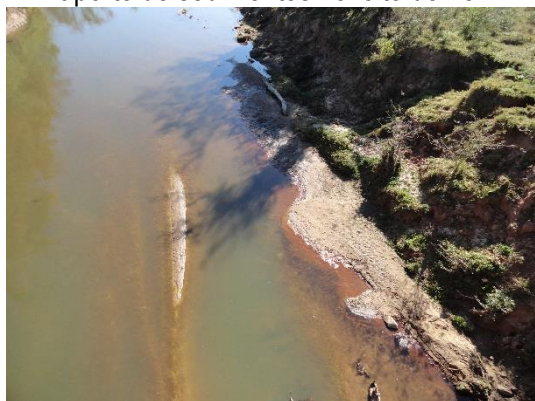
Figura 6: Margem esquerda do rio Anhumas, destaque para a erosão da margem e para o aporte de sedimentos no leito do rio.
