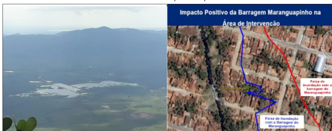
Figuras 2 e 3 – A barragem do Rio Maranguapinho vista da Serra de Maranguape (a esquerda) e as Faixas comparativas de inundação após a implantação da barragem do rio Maranguapinho pelo PROMURB (a direita)
