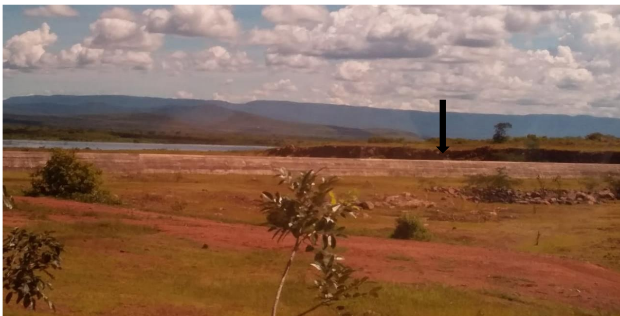
Figura 2- Visão da parede do Açude Taquara
