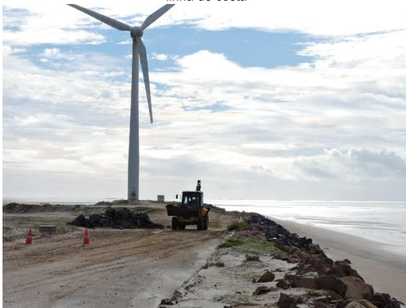
Figura 1: Manutenção do parque sendo realizada com a colocação de blocos de concreto ao longo da linha de costa
