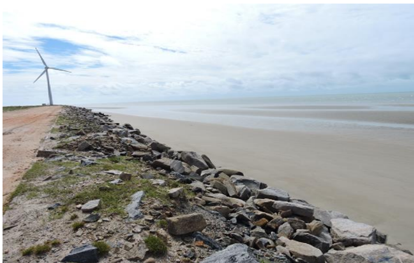
Figura 4: Vista de perfil da praia com a presença de blocos ao longo do perfil
