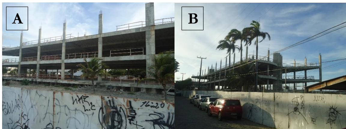
Figura 2: A: Acuario do Ceará em construção, com vista para a praia; B: Acuario do Ceará em construção, com vista para a rua principal.
