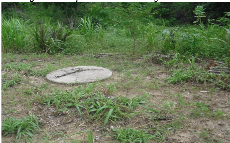
Figura 04 – Poço a montante da barragem subterrânea
