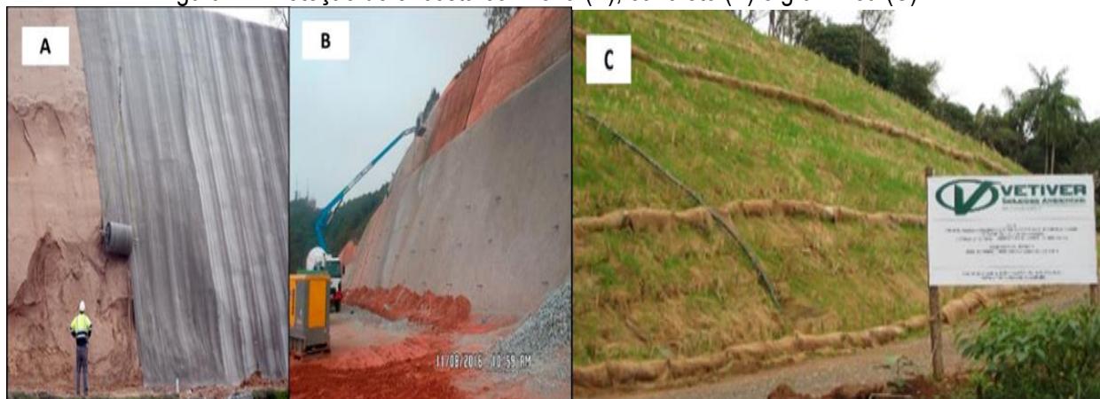
Figura 4 - Proteção de encosta com lona (A), concreto (B) e gramínea (C).
