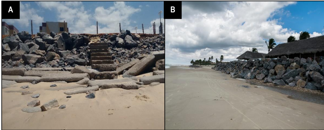
Figura 2 – Estruturas de contenção costeira construídas nas praias do Icaraí (A) e da Tabuba (B).
