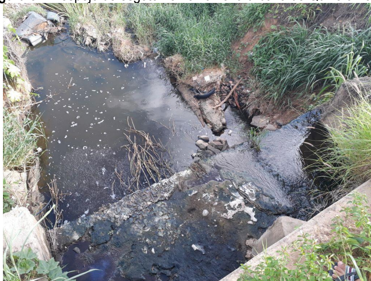
Figura 3 – Despejo de esgoto no rio na zona urbana de Quixeramobim
