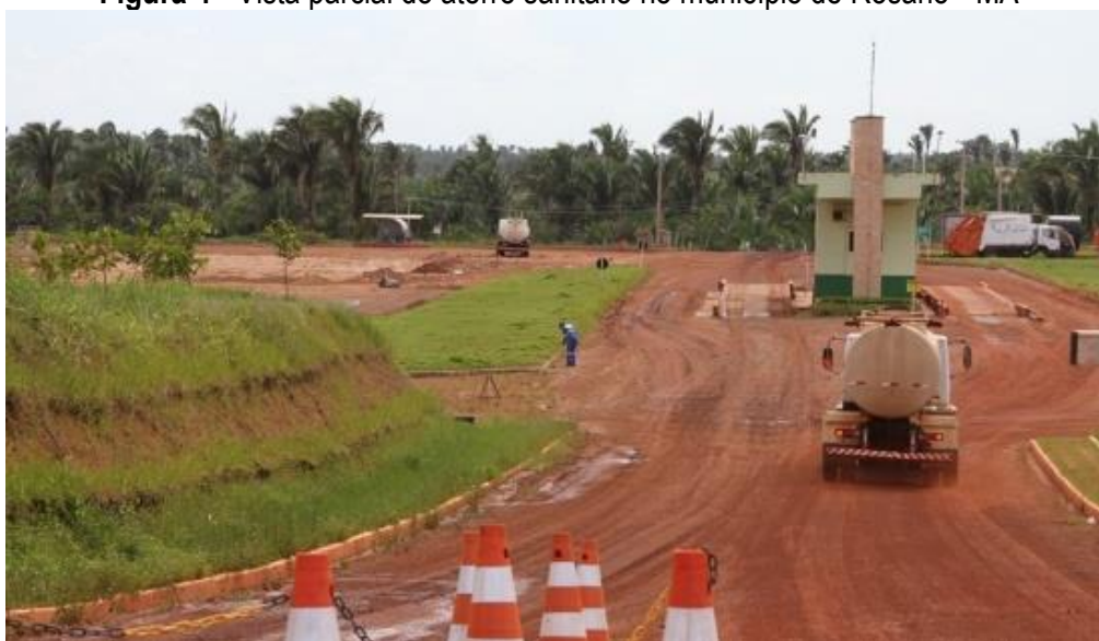
Figura 4 - Vista parcial do aterro sanitário no município de Rosário - MA
