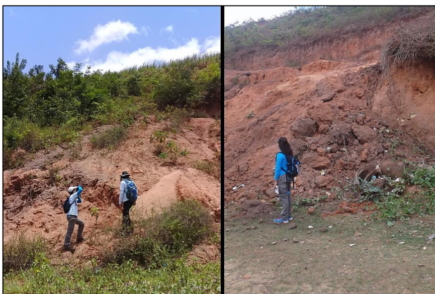
Figura 2: Ausência de vegetação e processos erosivos na encosta.
