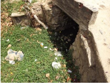
Foto 07: Ponto 05 (Vertedouro do açude público).
