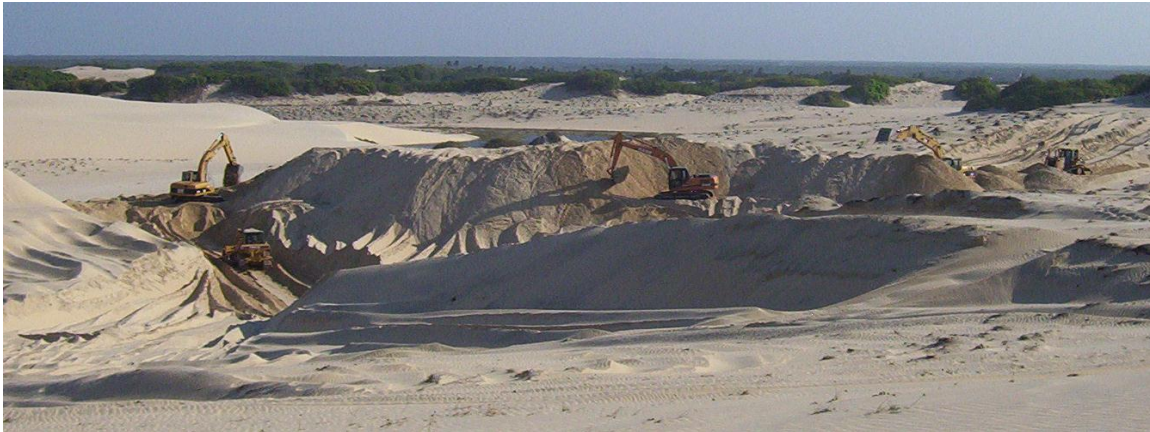
Figura 3. Fotografia de setembro/2007 que retrata o início da construção do parque eólico, em que pode ser visto o desmonte das dunas e a compactação do solo pelo maquinário da empresa.
