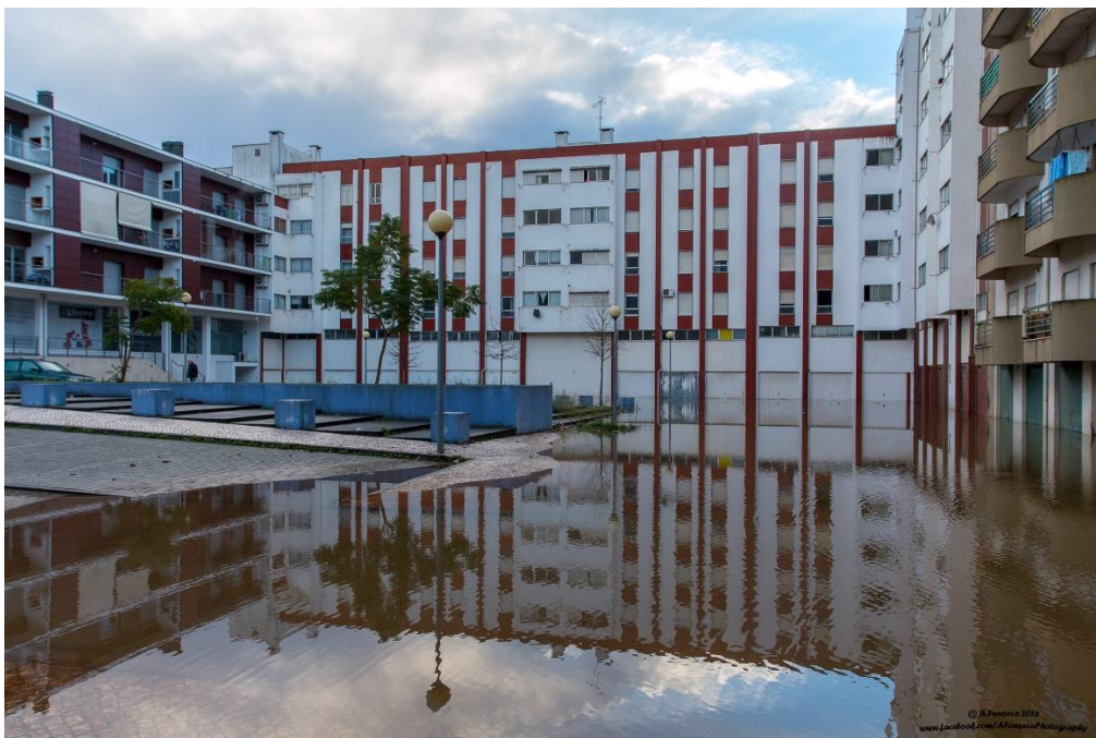
Figura 10. Garagens inundadas na Quinta da Várzea.
