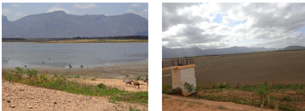
Figura 2 e 3: Açude Várzea da Volta
