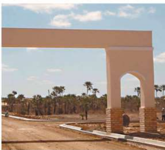
Arquitetura planejada para o bairro Vila União. O empreendimento está sendo desenvolvido em lotes de 125 metros quadrados.
