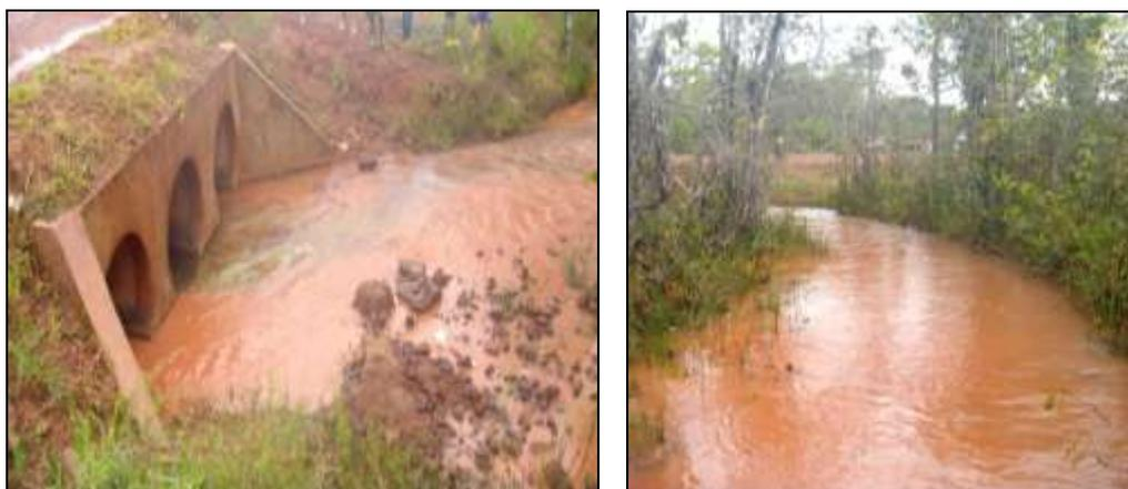
**Figuras 11 e 12:** Alteração da tonalidade das águas do rio Açú, a jusante da tubulação, em função do escoamento pluvial.
