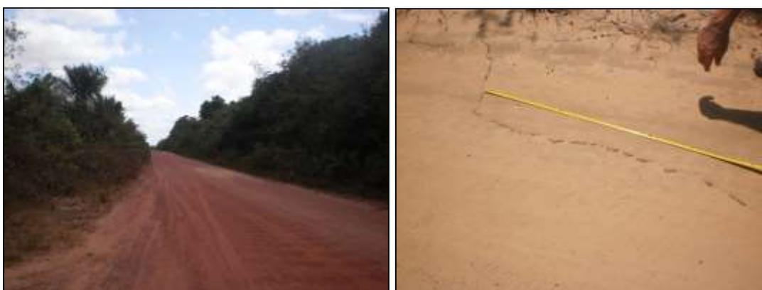
**Figura 05:** Vicinal sem asfaltamento e sem sistema de drenagem. **Figura 06:** Compactação do solo em vicinal. Observa-se a ocorrência de rachadura devido ao ressecamento e contração do solo. **Fonte:** a autora (14/12/12).
