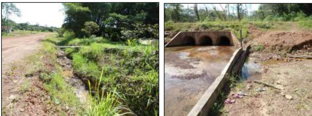
**Figura 09:** Formação de ravina em função do escoamento superficial nas margens da PA-375. **Figura 10:** Barras no leito fluvial em virtude da deposição de areias e cascalhos oriundos do material utilizado na pavimentação da estrada.
