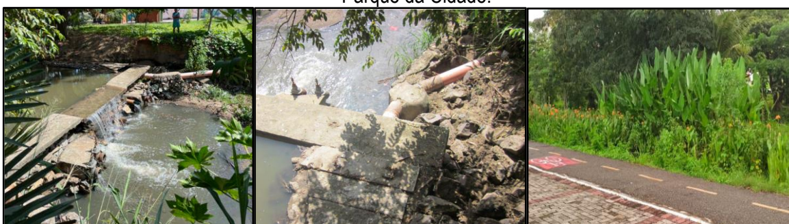
Figuras 2, 3 e 4: Caixa de areia, ramal de distribuição e unidade de alagado construído, situados no Parque da Cidade.
