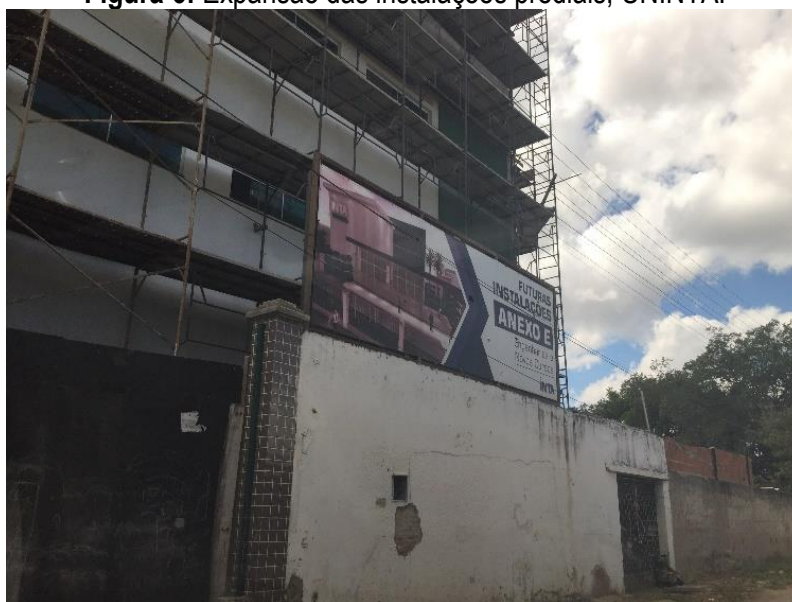
Figura 6: Expansão das instalações prediais, UNINTA.
