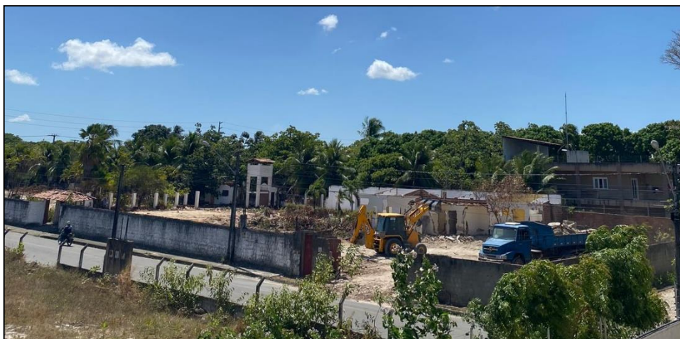
Figura 6: Processo de demolição para construção de um novo empreendimento no Eusébio.
