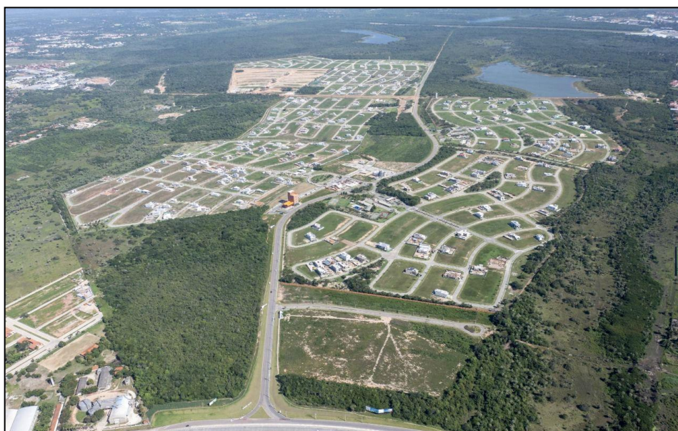
Figura 4: Vista aérea da Cidade Alpha.
