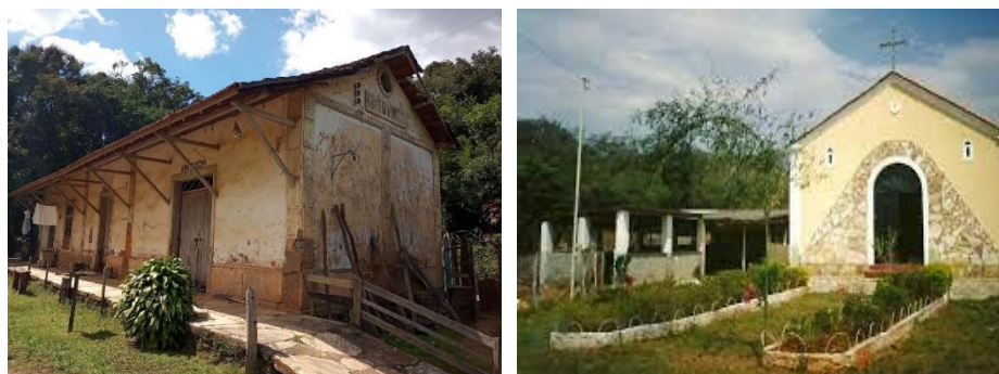
Figura 7: a) A desativa estação do povoado do Ibitutinga; b) Capela de São Domingos Sávio, padroeiro do povoado do Ibitutinga.
